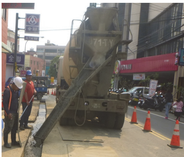
天然氣管線汰換施作情形
