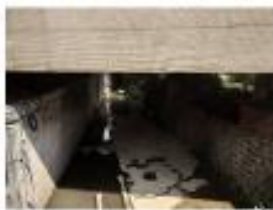
茄冬溪支線現況
