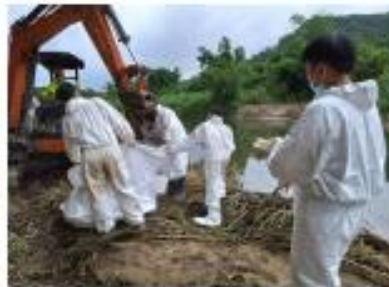
邊坡之泥土深層污染物清除，使用吸液棉及砂土吸附稀釋挖除，再使用吊車吊掛，共清運7袋太空包，移至資收場暫置。
