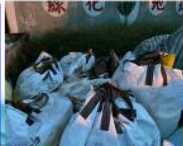
邊坡之泥土深層污染物清除，使用吸液棉及砂土吸附稀釋挖除，再使用吊車吊掛，共清運7袋太空包，移至資收場暫置。
