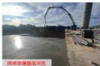
爬坡車道基座澆置
