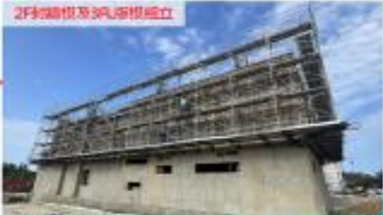
2F封牆模及3FL版模組立
