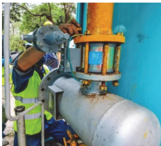
高鐵區嘉政九整壓站檢測及更新軸流閥
