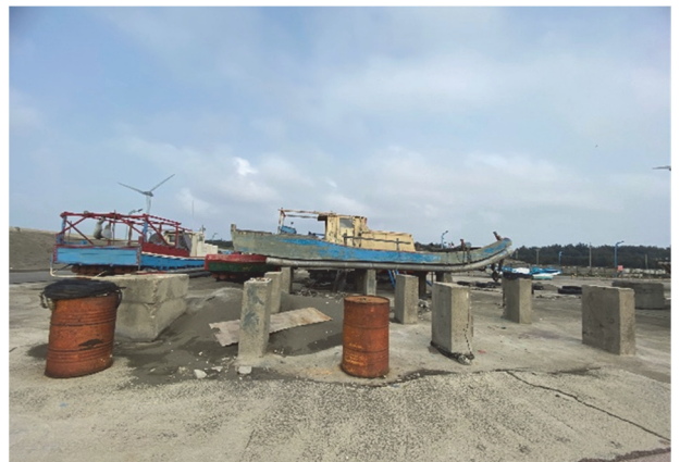
部分漁船占用港區陸地
